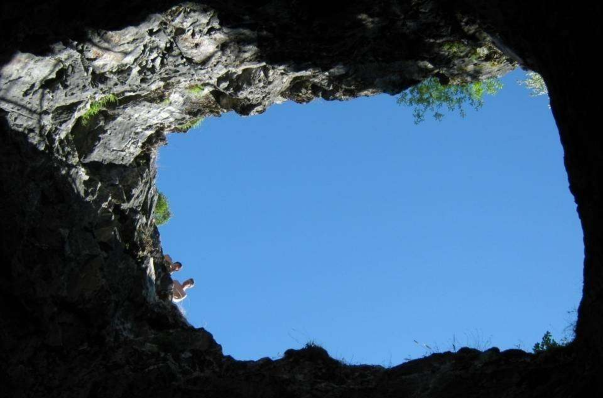
Сечение шахты № 2 почти прямоугольной формы, размером 5 x 7.5 м
