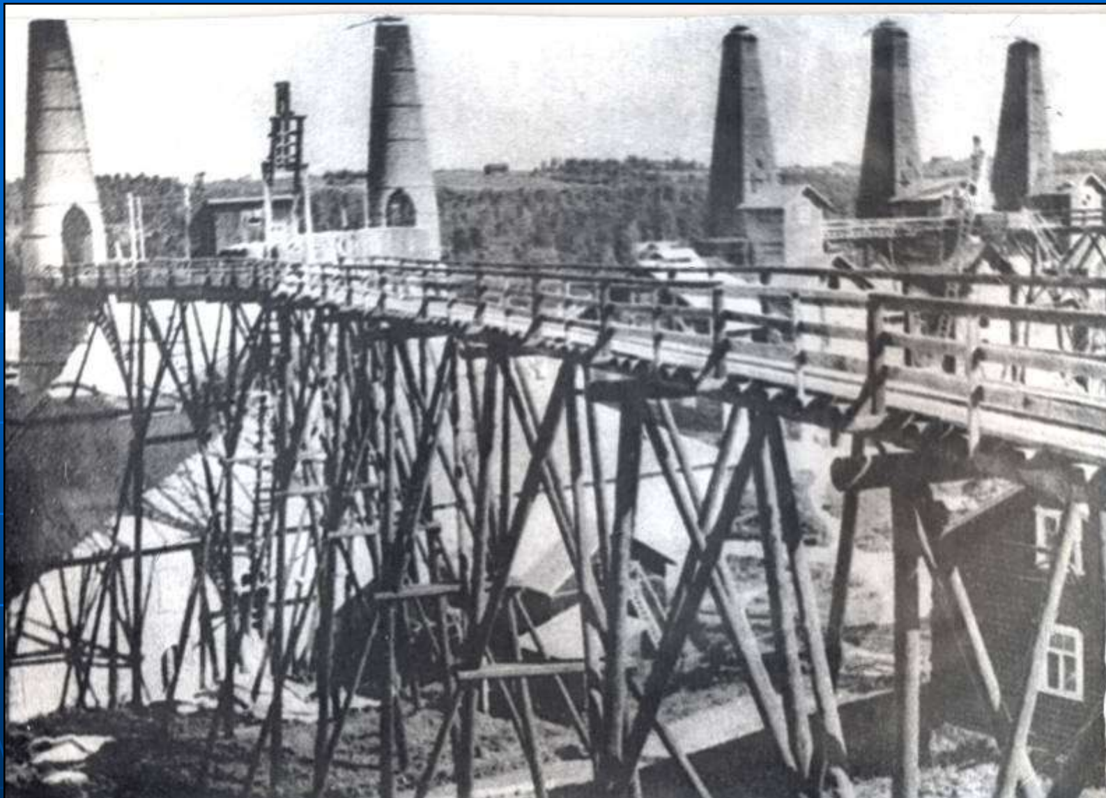
Мрамор к обжиговым печам Рускеальского завода везли в вагонетках по узкоколейным железным дорогам, укрепленным на высоких опорах. 1939 г.
