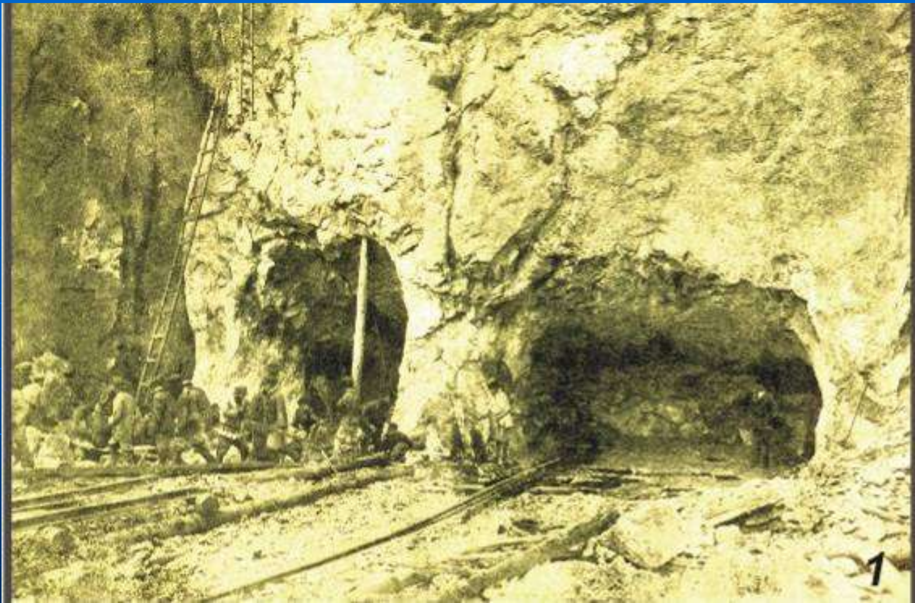
Проходка горизонтального рва («подкопа» или «подгорья») в подошве карьера. Белая Гора в Тивдии. 1901 г.
